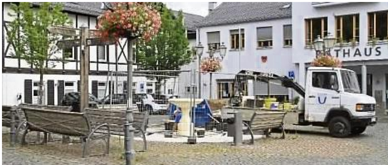
Der weiche Stein aus Frankreich hat der Witterung im Taunus nicht standgehalten – die Sanierung des Le Mêle-Brunnens vor dem Rathaus läuft derzeit. Sie soll Ende August abgeschlossen sein.
