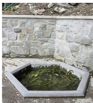
Fadenalgen machen einen engeren Reinigungstakt des Pulverbrunnens durch den Betriebshof erforderlich.
